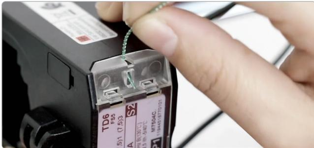
Una vez colocada la tapa cubrebornes, se procede al precintado del transformador.
